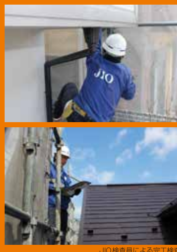
JIO検査員による完工検査
