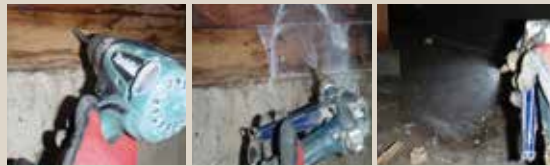
穿孔注入処理 吹付処理/土壌処理 土壌処理
